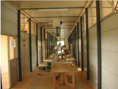
■仮設校舎内観 ①
